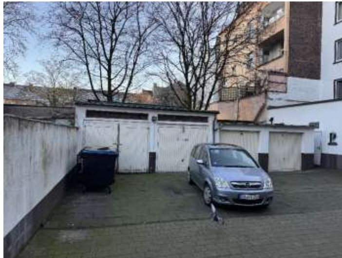
Bild 7: Ansicht Hof und Garagen
