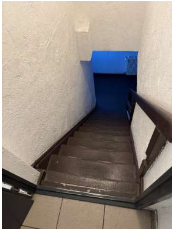
Bild 34: Kellertreppe vom Erdgeschoss
