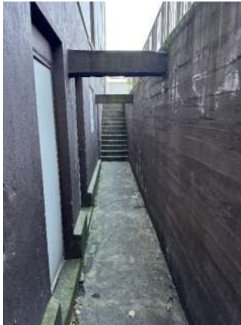
Bild 9: Außenliegender begehbare Kellerschacht
