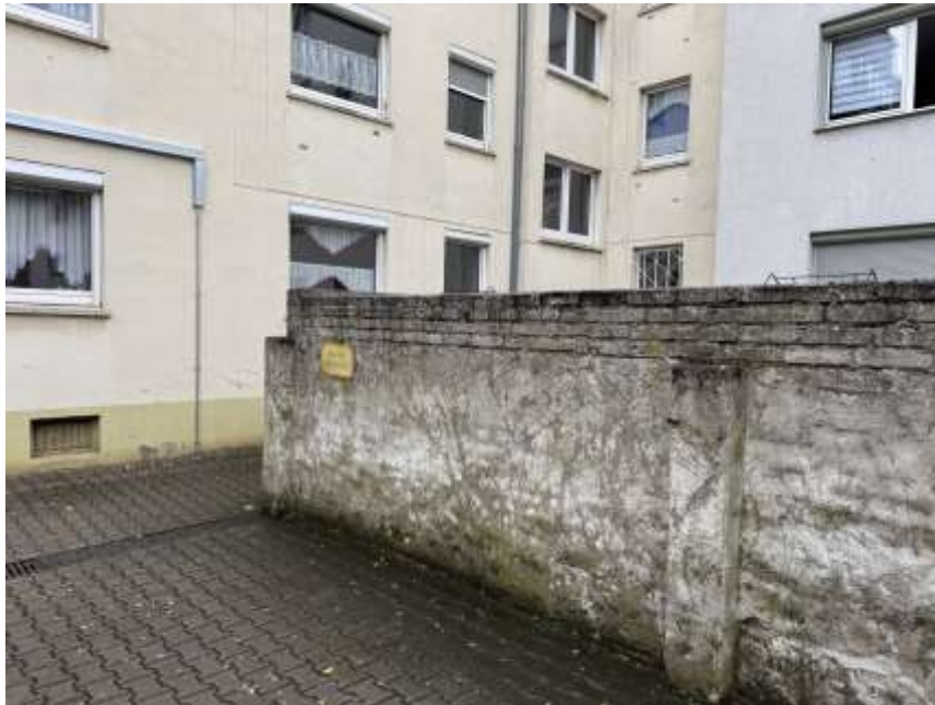
Bild 15: Schadensbild Einfriedungssmauer
