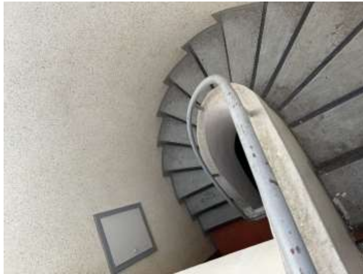
Bild 17: Geschosstreppe zum OG
