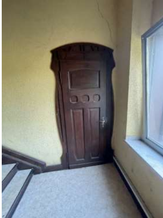
Bild 11: Abstellraum auf halber Etage
