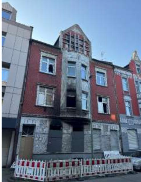
Bild 1: Straßenansicht mit erkennbarem Brandschaden an der Fassade
