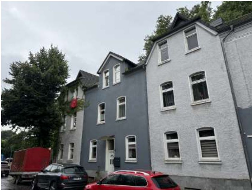
Bild 2: Straßenansicht Haus Seydlitzstr. 56
