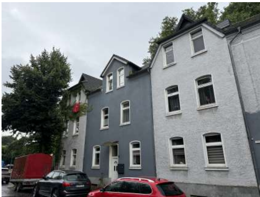
Bild 2: Straßenansicht Haus Seydlitzstr. 56
