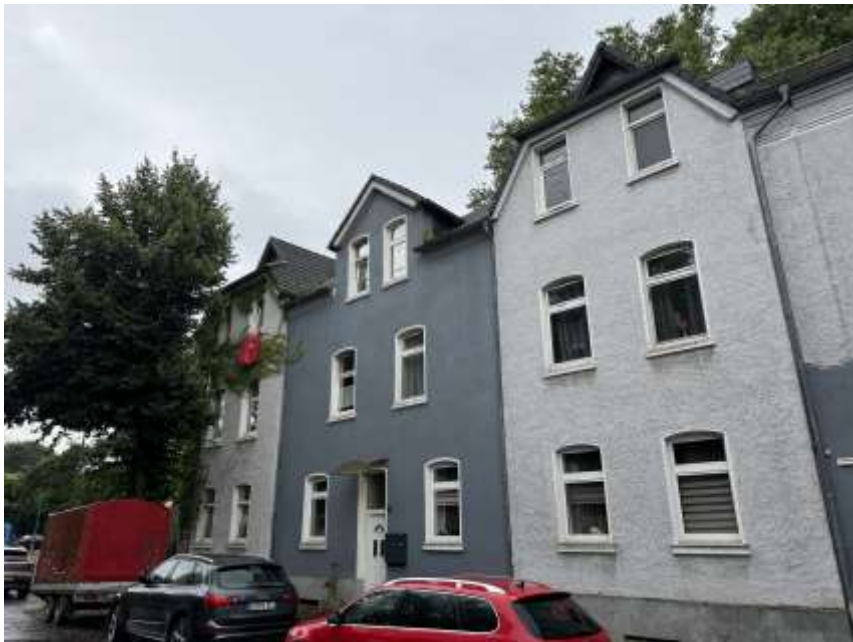
Bild 2: Straßenansicht Haus Seydlitzstr. 56
