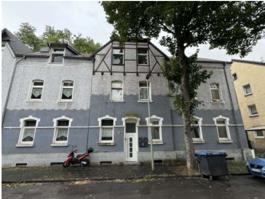
Bild 3: Straßenansicht Haus Seydlitzstr. 54
