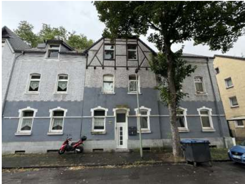
Bild 3: Straßenansicht Haus Seydlitzstr. 54
