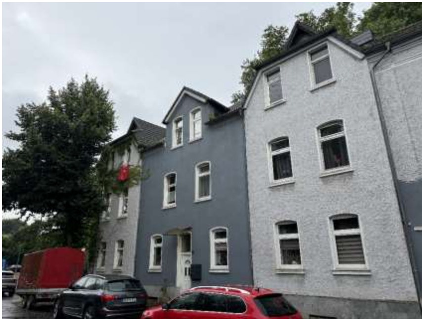
Bild 2: Straßenansicht Haus Seydlitzstr. 56
