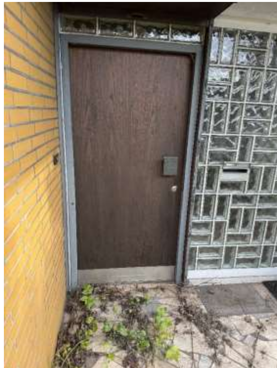
Bild 10: Eingangsbereich SE Nr. 3
