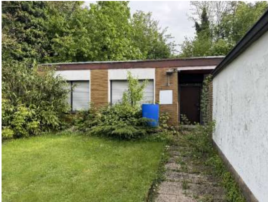
Bild 1: SE Nr. 3 Hintergebäude
