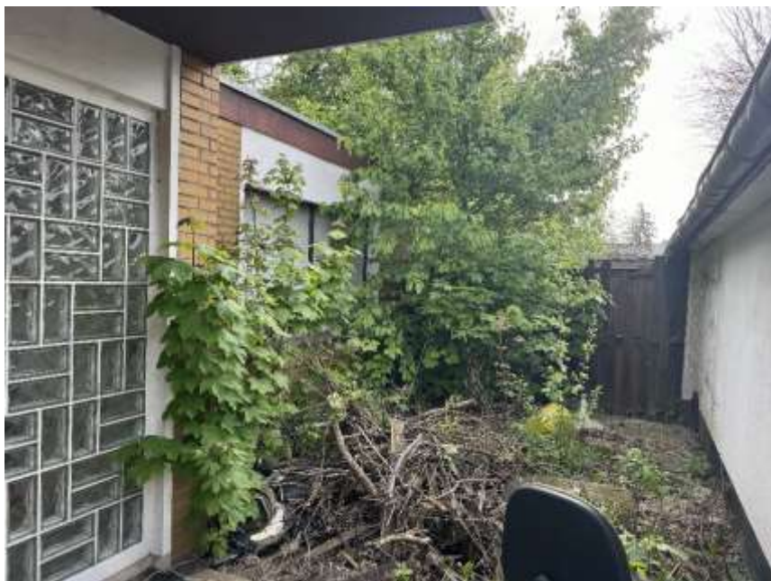
Bild 2: SE Nr. 3 Hintergebäude
