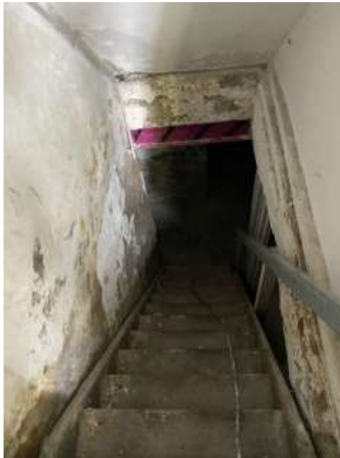
Bild 11: Zugang zum Kellergeschoss (nicht begangen)
