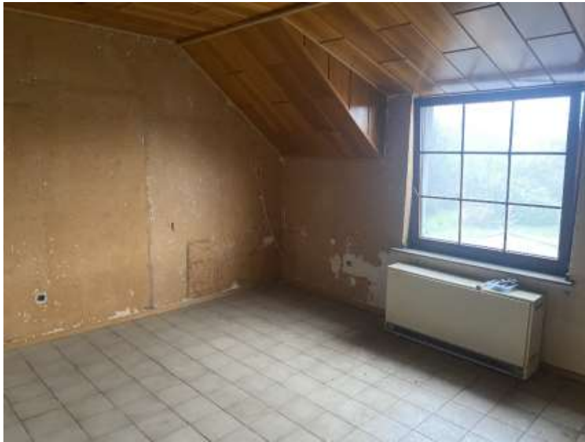
Bild 39: Innenansicht Wohnung 2. OG
