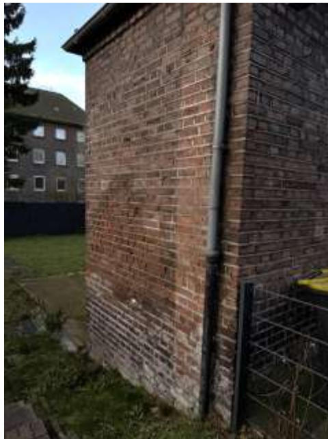
Bild 8: Schadensbild Ziegelfassade
