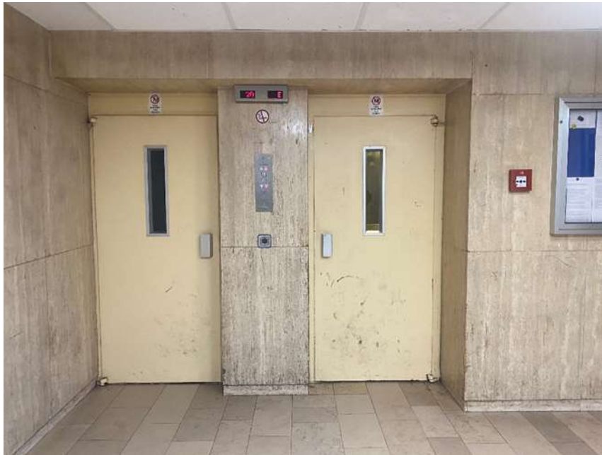
Bild 3: Eingangsbereich mit Fahrstühlen
