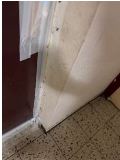
Bild 5: Schadensbild (Schädlingsbefall)
