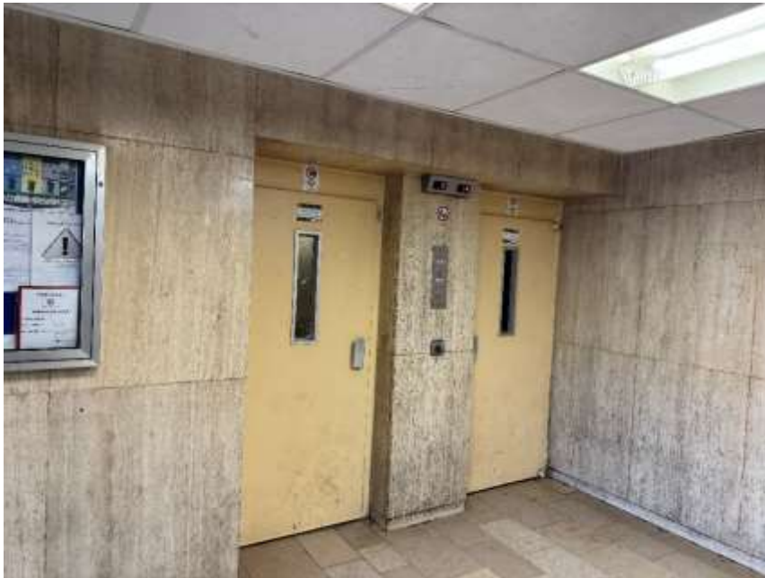
Bild 3: Eingangsbereich mit Fahrstühlen
