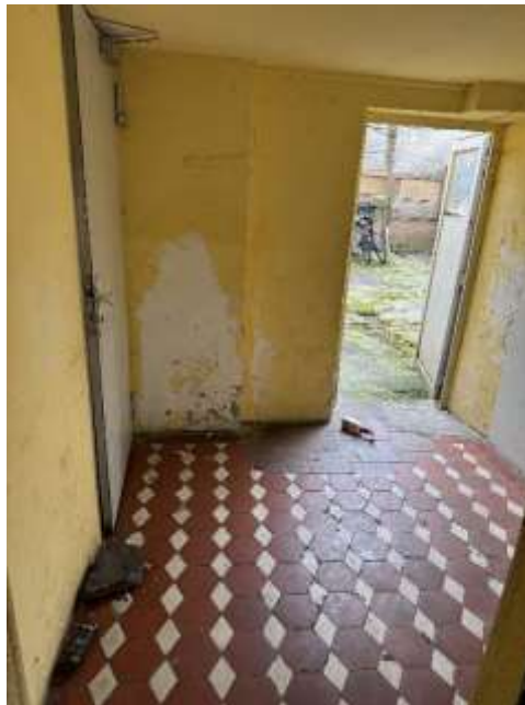
Bild 10: Treppenhaus mit Hofausgang
