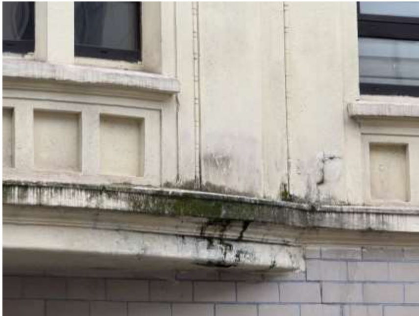
Bild 25: Schadensbild Fassade
