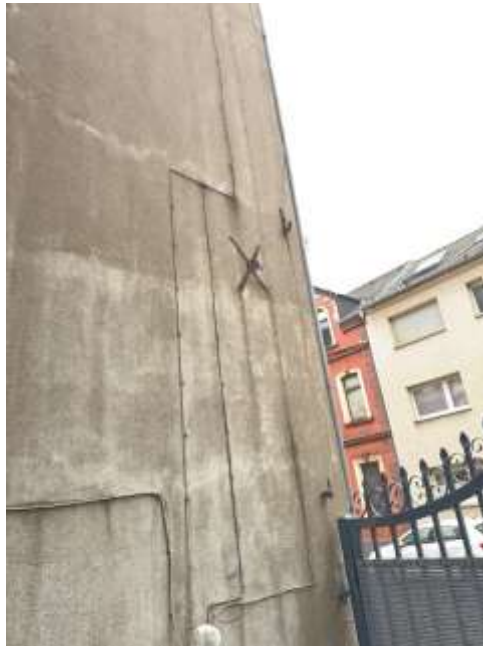
Bild 53: Detailansicht giebelseitige Fassade
