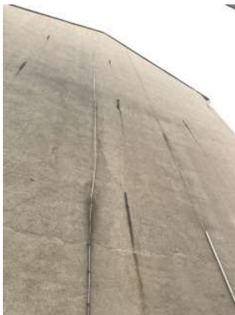
Bild 52: Detailansicht giebelseitige Fassade
