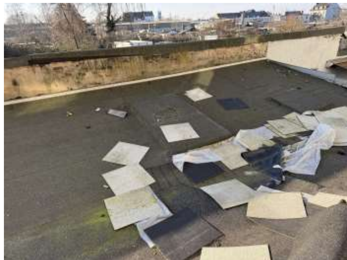
Bild 16: Draufsicht Flachdach Anbau
