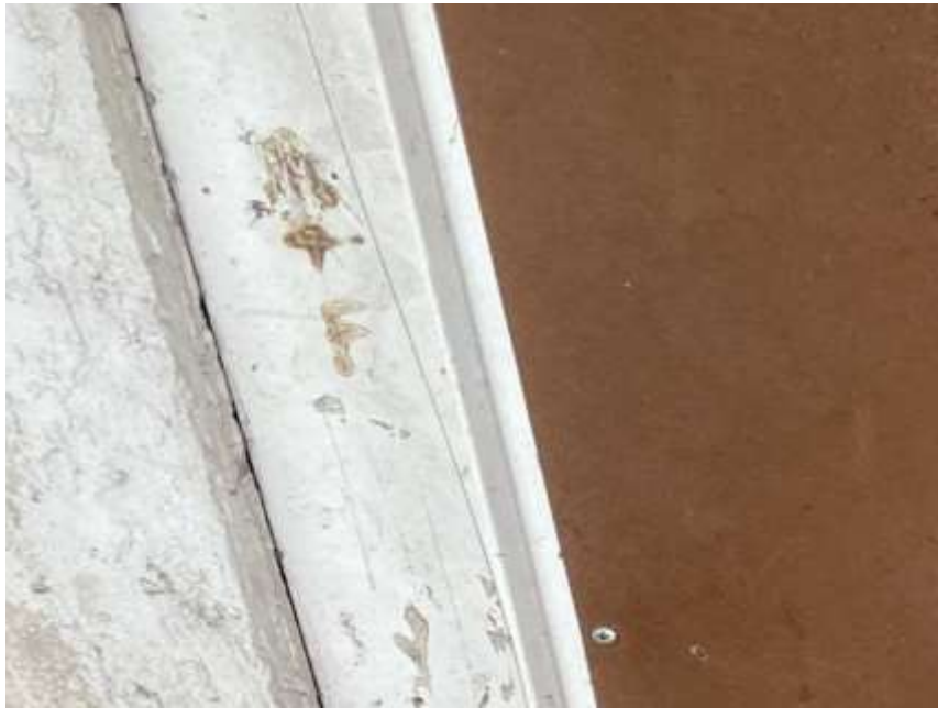
Bild 11: Versiegelte Bautür durch die Taskforce
