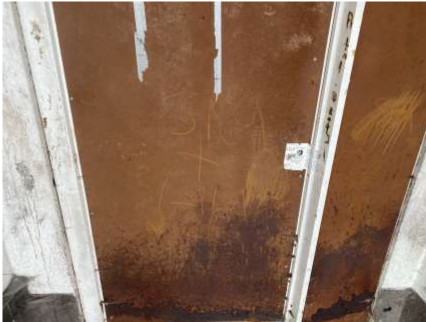
Bild 11: Versiegelte Bautür durch die Taskforce
