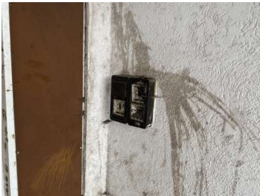
Bild 12: Beschädigte Klingelanlage
