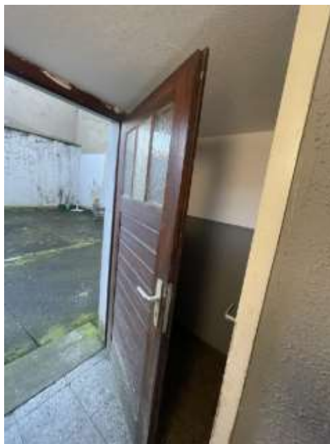
Bild 8: Hofeingangstür vom Treppenhaus
