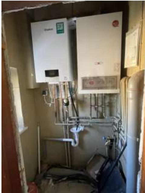
Bild 15: Gasetagenheizung
