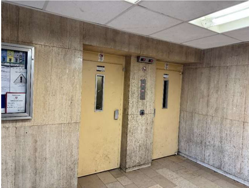
Bild 3: Eingangsbereich mit Fahrstühlen
