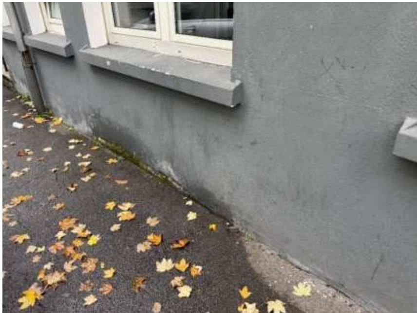
Bild 28: Feuchtigkeitsmerkmale Anbau
