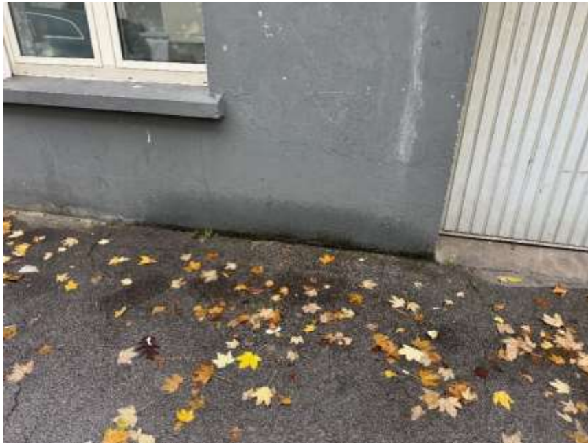
Bild 27: Feuchtigkeitsmerkmale Anbau
