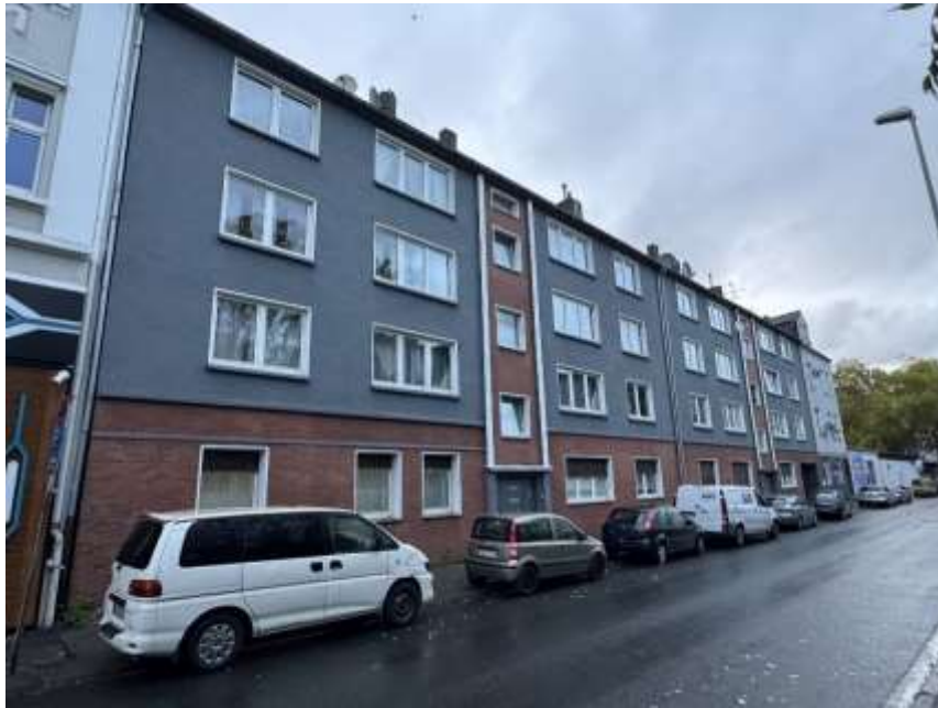
Bild 3: Straßenansicht Dahlmannstr. 3 und 5
