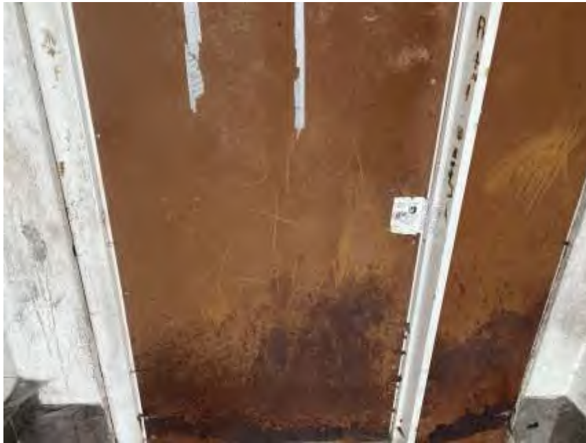
Bild 11: Versiegelte Bautür durch die Taskforce
