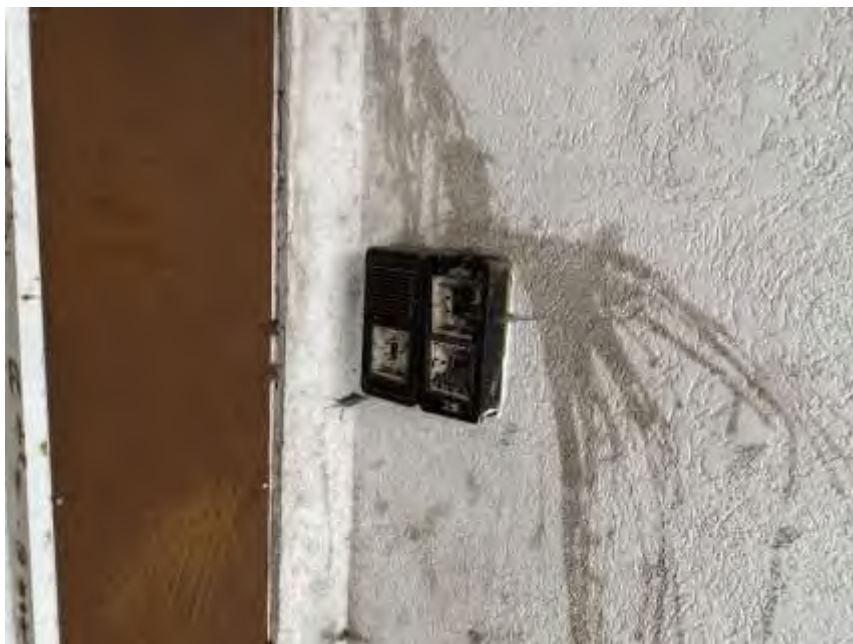
Bild 12: Beschädigte Klingelanlage
