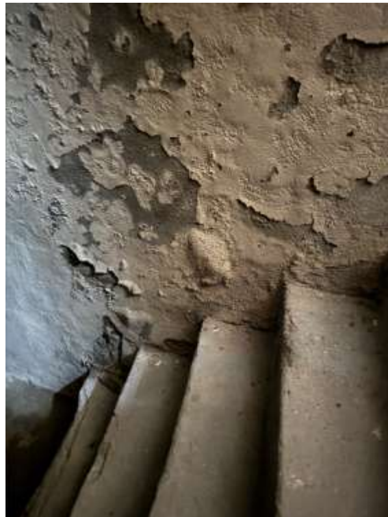
Bild 34: Schadensbild Kellermauerwerk
