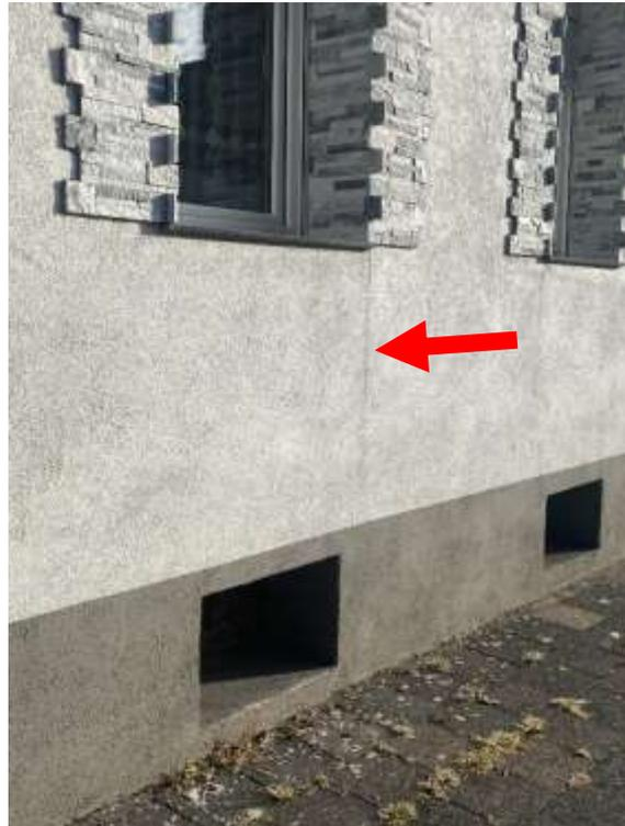
Bild 5: Schmutzfahnen an der straßenseitigen Fassade
