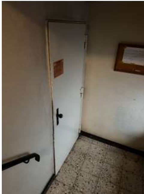
Bild 5: Zugang zum Kellergeschoss
