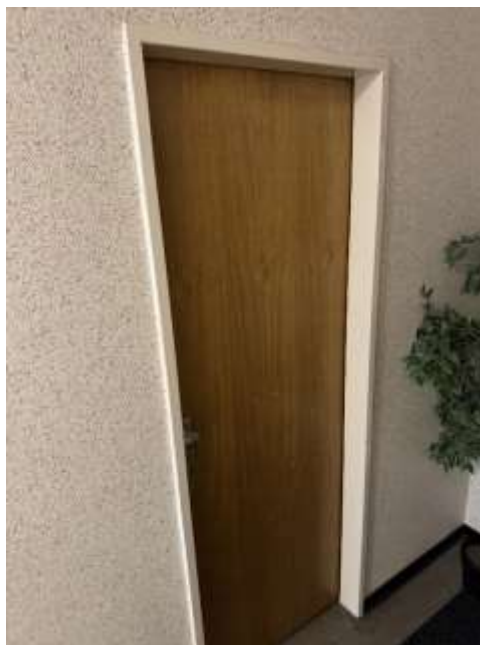
Bild 16: Eingangstür zum Abstellraum
