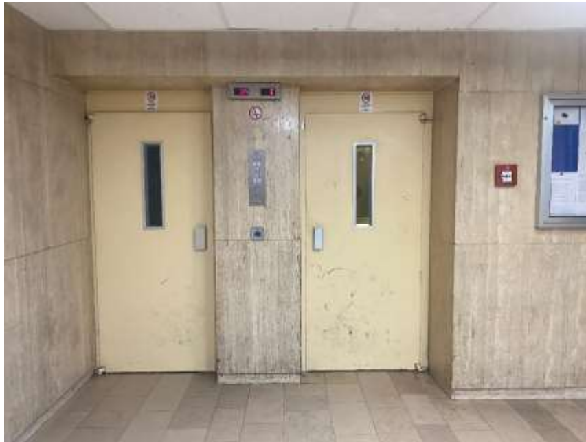
Bild 3: Eingangsbereich mit Fahrstühlen
