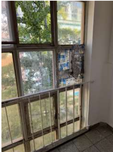
Bild 5: Treppenhaus beschädigtes Fenster
