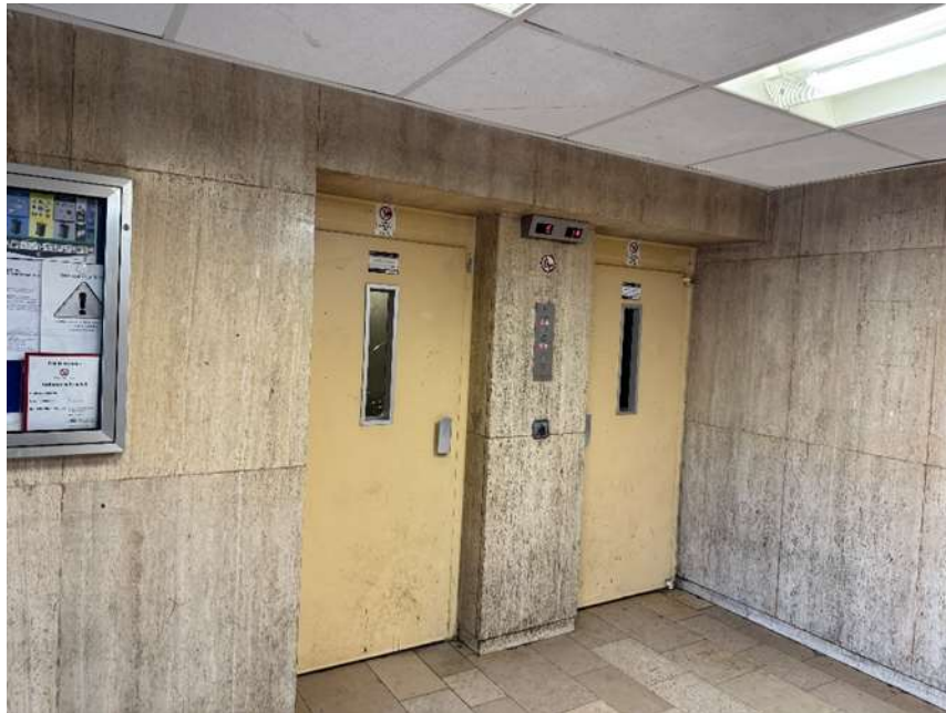
Bild 3: Eingangsbereich mit Fahrstühlen
