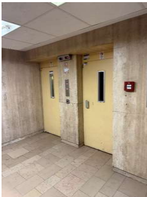
Bild 3: Eingangsbereich mit Fahrstühlen
