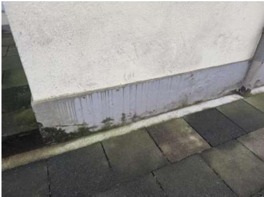
Bild 12: Feuchtigkeitsmerkmale im Sockelbereich der Fassade
