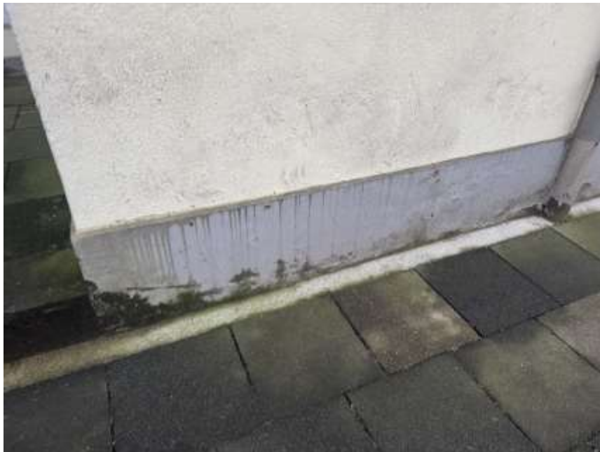
Bild 12: Feuchtigkeitsmerkmale im Sockelbereich der Fassade
