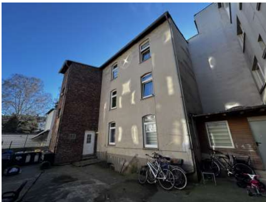
Bild 3: Ansicht des Hofgebäudes
