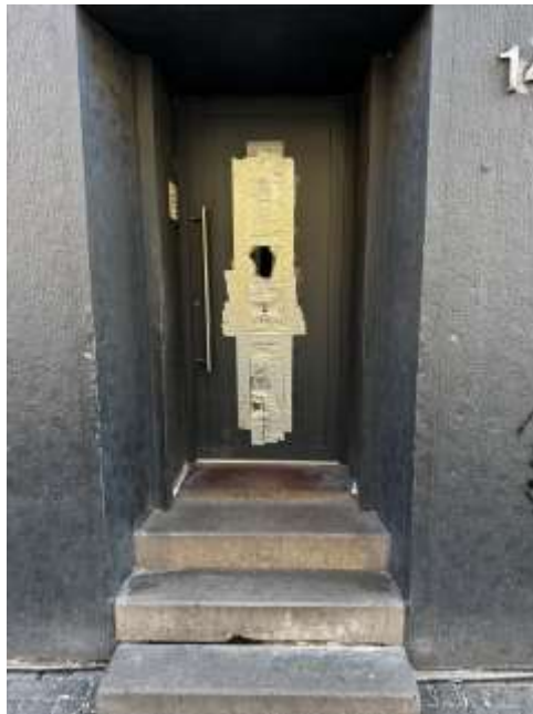
Bild 7: Ansicht des Hauseingangs (Vorderhaus)
