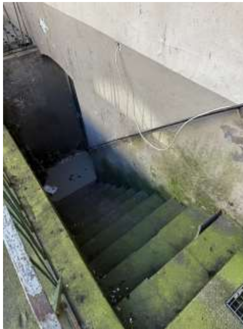
Bild 9: Ansicht der Kelleraußentreppe
