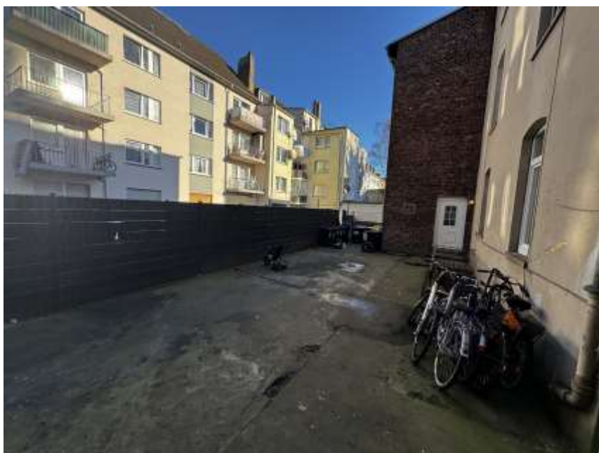
Bild 4: Ansicht der Hoffläche
