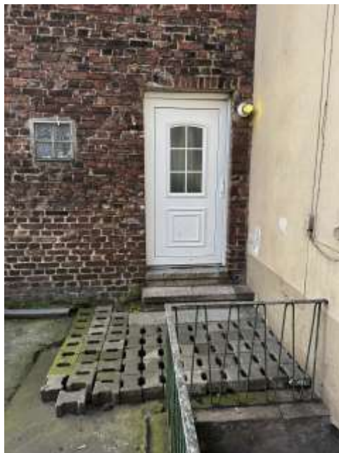
Bild 8: Ansicht des Hauseingangs (Hofgebäude)
