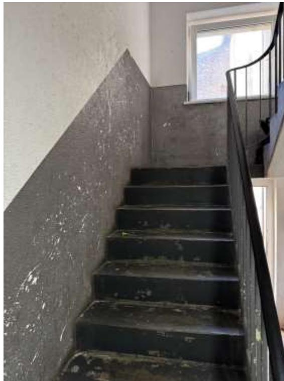
Bild 11: Innenansicht des Treppenhauses
