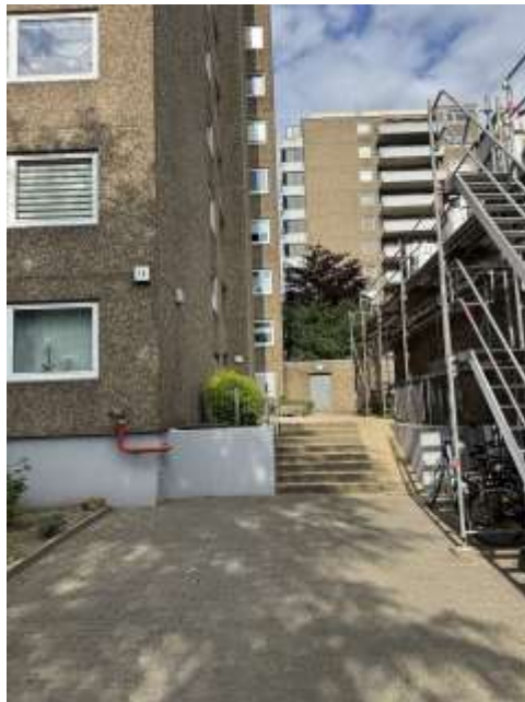
Bild 2: Zugang Eingang Weißdornstr. 15
