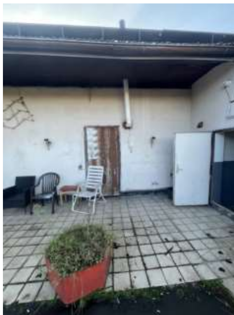
Bild 32: Terrassenfläche auf dem Dach
