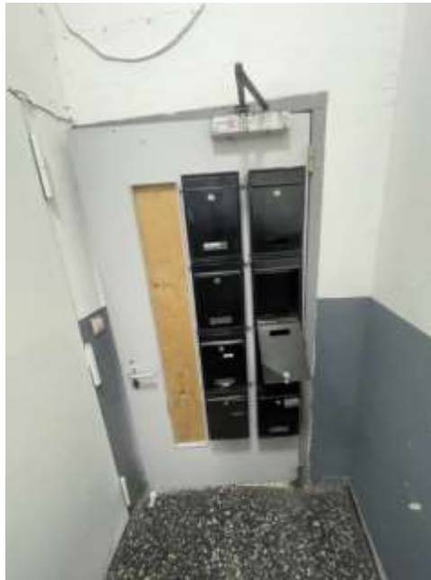
Bild 17: Hauseingangstür Kaiser-Friedrich-Straße von innen
