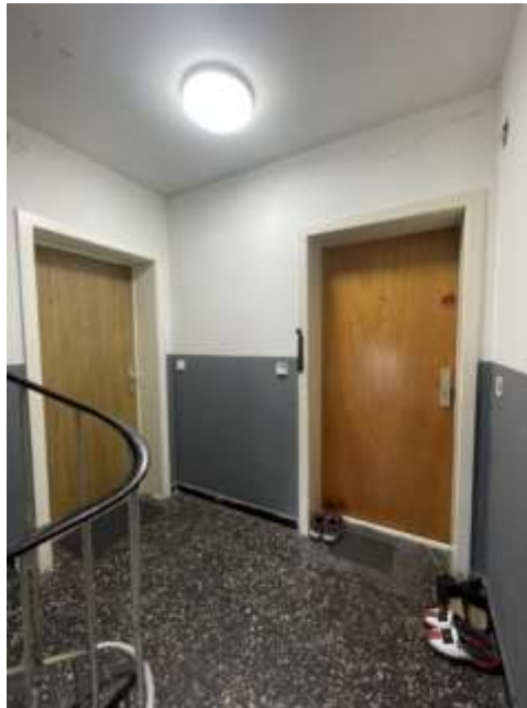
Bild 31: Treppenhaus 3.OG Kaiser-Friedrich-Straße
