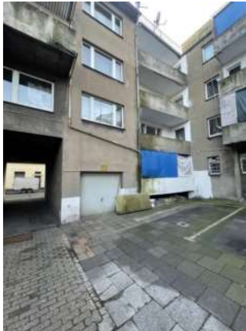
Bild 13: Rückansicht mit Ansicht auf Garage Nr. 3
