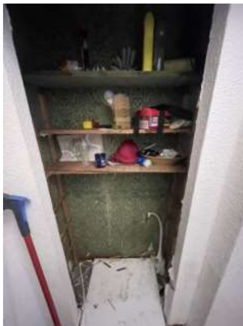
Bild 50: Abstellkammer Wohnung Roonstraße 69 2.OG links
