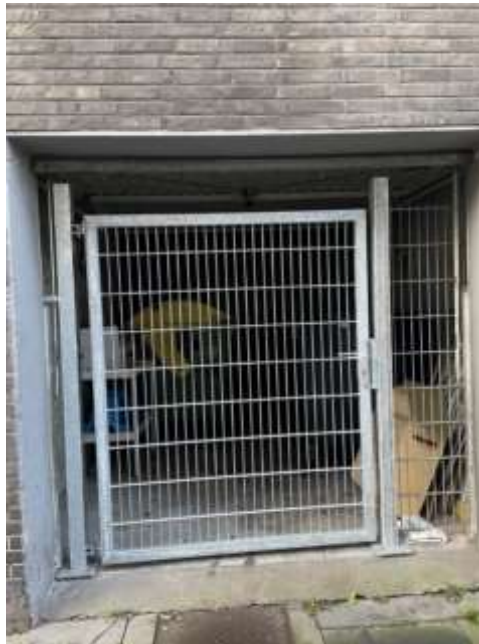
Bild 15: Garage Nr. 2; umgenutzt zum Mülltonnenstellplatz
