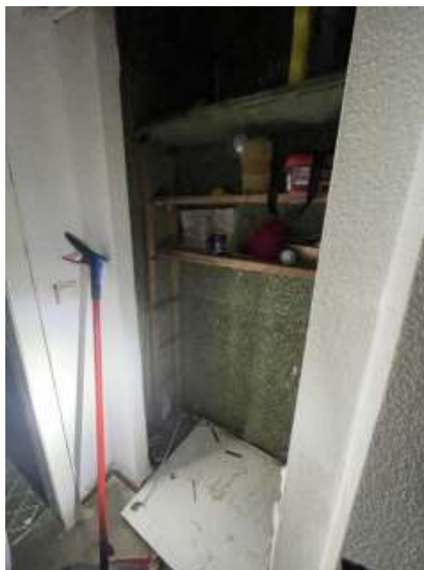
Bild 48: Abstellkammer Wohnung Roonstraße 69 2.OG links
