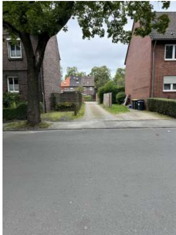
Bild 5: Zufahrtsbereich zu den Garagen
