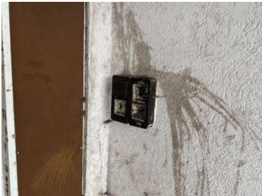
Bild 12: Beschädigte Klingelanlage
