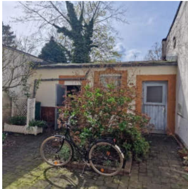
Anbau im hinteren Grundstücksteil
