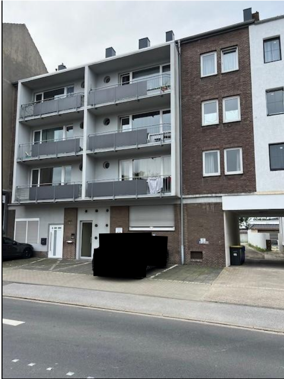
Straßenansicht mit Durchfahrt
