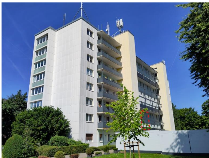
Straßenseitige Ansicht mit Markierung der Wohnung
