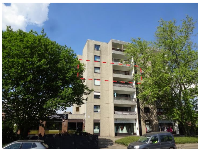
Ansicht von der Anrather Straße
