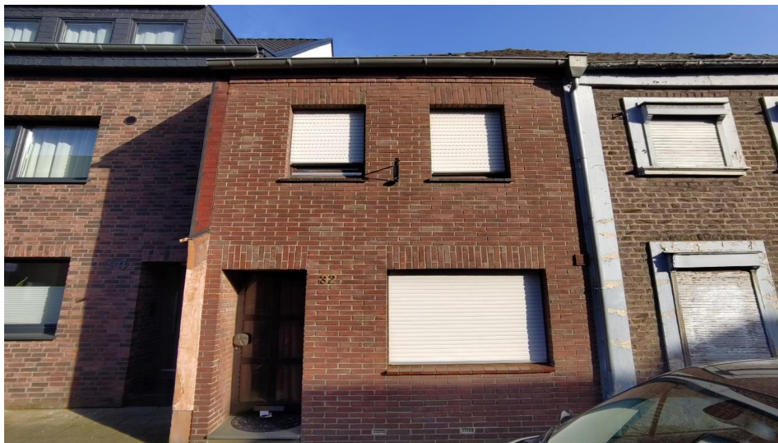
Straßenseite Ansicht des Hauses Neustraße 32
