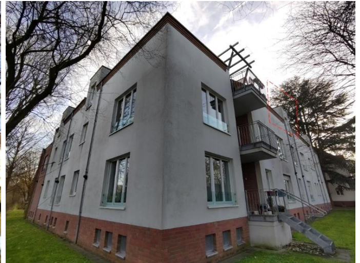
Rückseitige Ansicht (mit Markierung der Wohnung)
