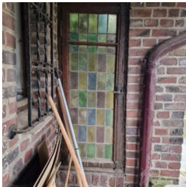
Bleiverglastes Fenster am Windfang
