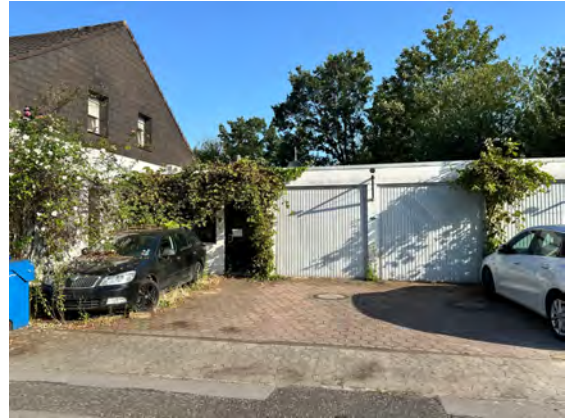
Stellfläche mit 2 Schachtbauwerken
