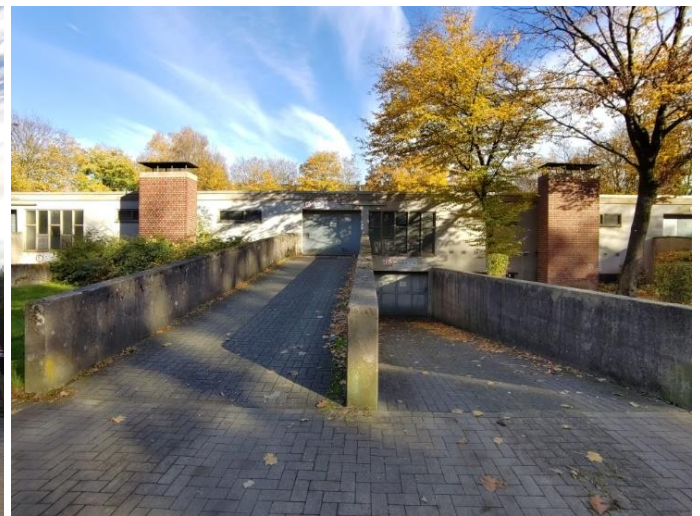
Straßenseitige Ansicht der Großgarage
